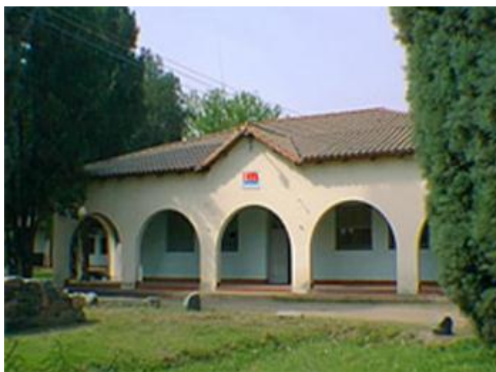
FIGURA N° 3. Foto de la Estación Experimental Catamarca. Edificio Central.
